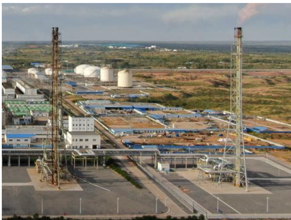
火炬系统（左侧一期年产 100 万吨合成氨 175 万吨尿素项目 右侧为合成气制年产 100 万吨甲醇技术改造项目）
