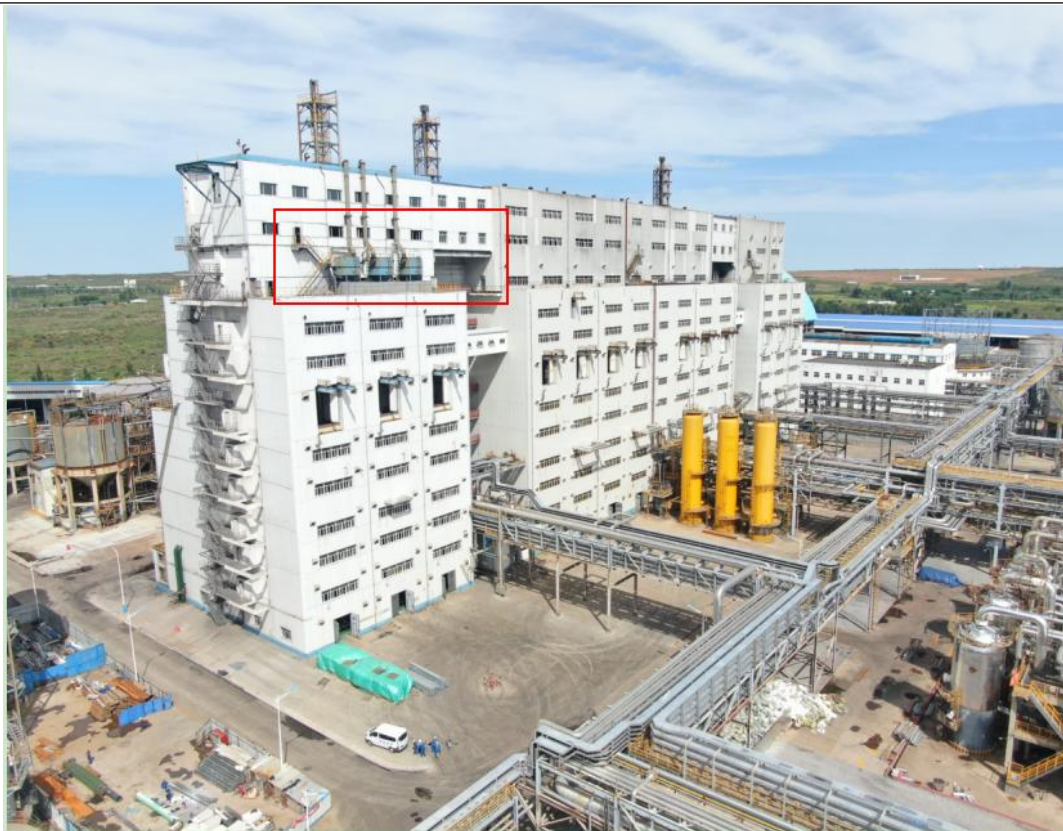
煤仓除尘器在气化框架位置
